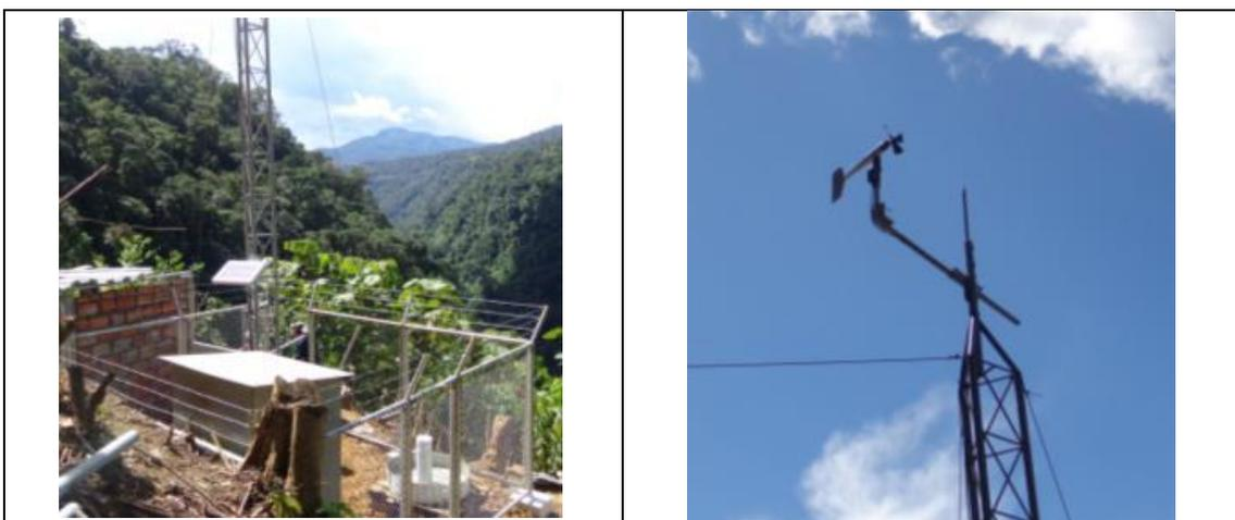
Fotografía 32: Estación Meteorológica G-8 - Sensor de velocidad y dirección del viento, pararrayos.
