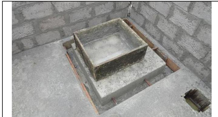
Fotografía 38: Dado del sensor asilado de la losa de la estructura de la caseta
