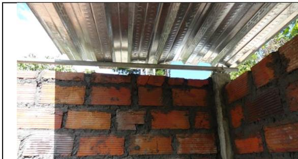
Fotografía 40: Instalación de la nova-losa en la estación sismológica antes de ser ahogada en concreto
