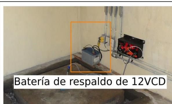
Fotografía 54: Alimentación del equipo desde una fuente conmutada de 12VCD
