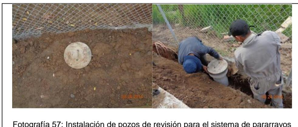
Fotografía 57: Instalación de pozos de revisión para el sistema de pararrayos
