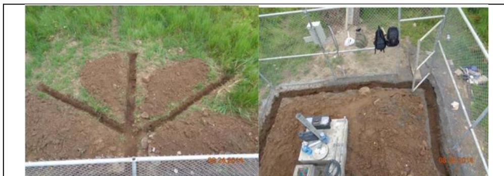
Fotografía 55: Zanjas para la instalación de la malla a base de varillas
