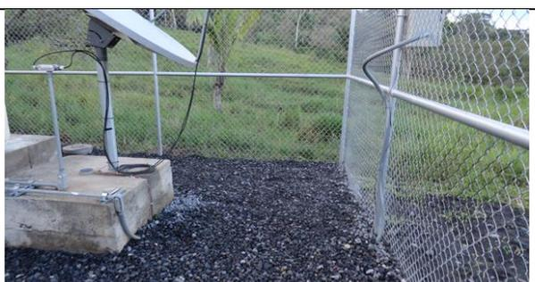
Fotografía 43: Canalización de la línea de 120VAC hacia la estación
