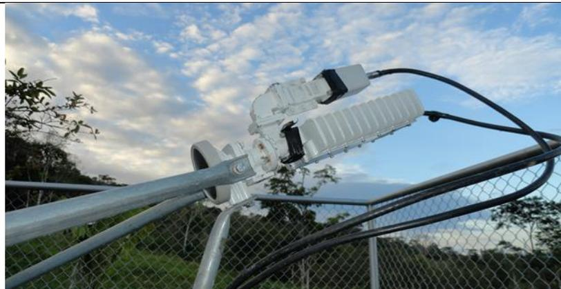
Fotografía 50: Electrónica de la antena satelital, compuesta por un supra-convertidor de bloque (BUC) para banda Ku y un amplificador de bajos ruido (LNB) con seguidor de fase cerrada(PLL) para banda Ku
