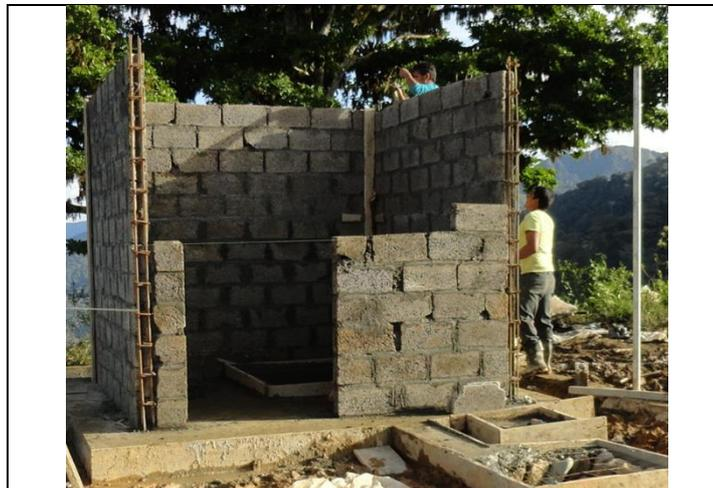
Fotografía 39: Colocación de las columnas en la estación sismológica
