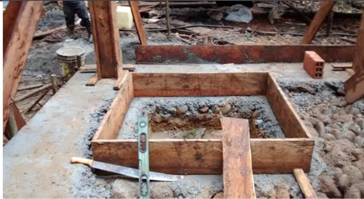
Fotografía 61: Preparación para el dado del sensor dentro de la caseta
