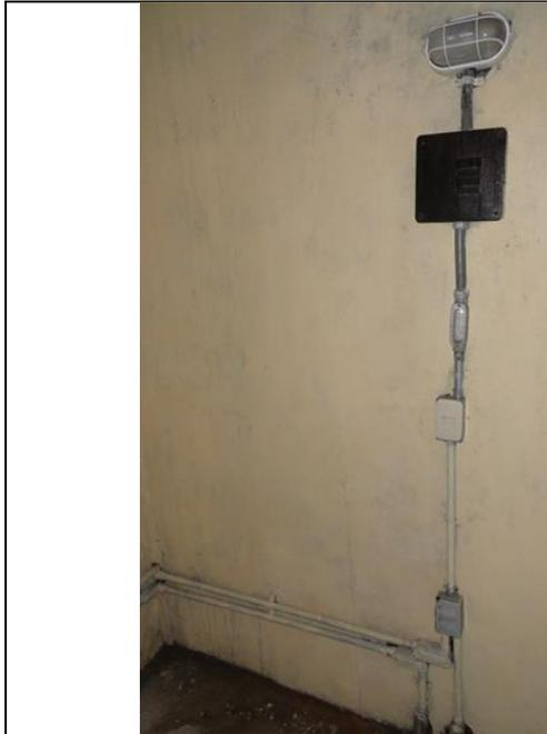
Fotografía 44: Distribución de la línea de 120VAC en el interior de la caseta
