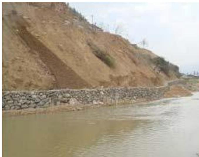
Fotografía 11: Muros de contención al pie de talud
