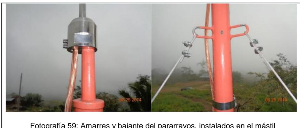
Fotografía 59: Amarres y bajante del pararrayos, instalados en el mástil
