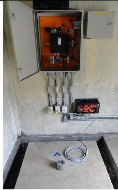
Fotografía 45: Distribución de la línea de 120VAC hacia los equipos de medición y comunicaciones
