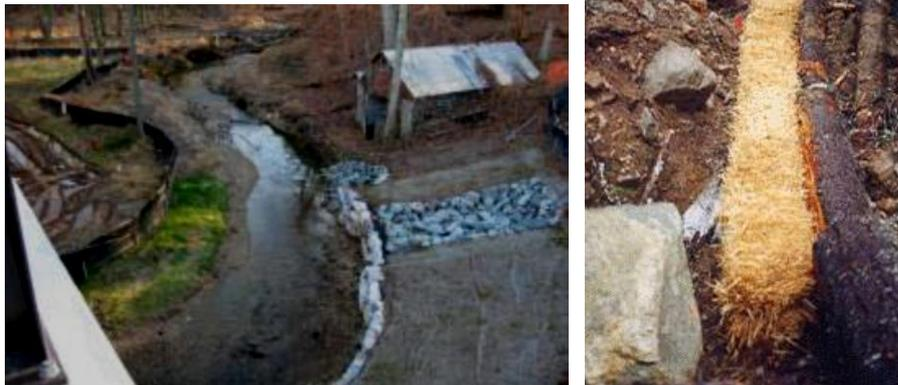
Fotografía 14: Obras para evitar el escurrimiento y erosión de taludes
