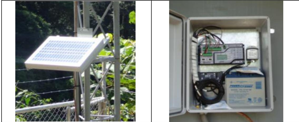
Fotografía 33: Panel solar del sistema de energía autónomo – Data logger y barómetro.
