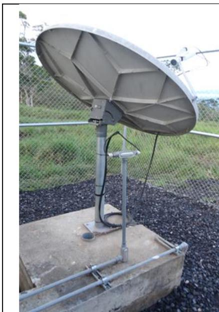
Fotografía 51: Canalización exterior del cableado del sistema satelital
