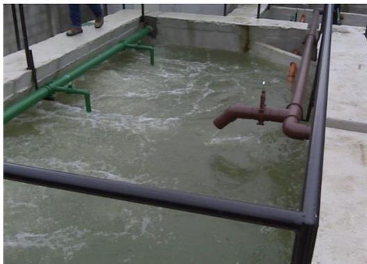
Fotografía 4: Digestor de lodos
