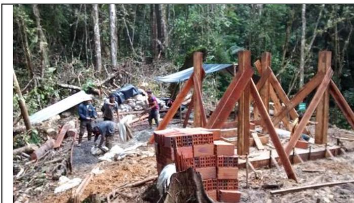
Fotografía 62: Colocación de las columnas en una estación sismológica
