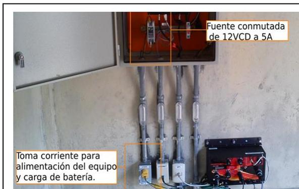
Fotografía 53: Alimentación del equipo desde una fuente conmutada de 12VCD
